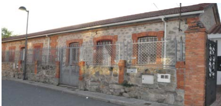
Vivienda en la calle Corta
