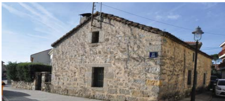
Vivienda en la calle de la Fuente
