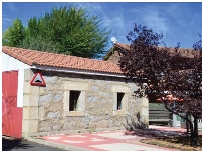
Casilla del ferrocarril o de ferroviarios
