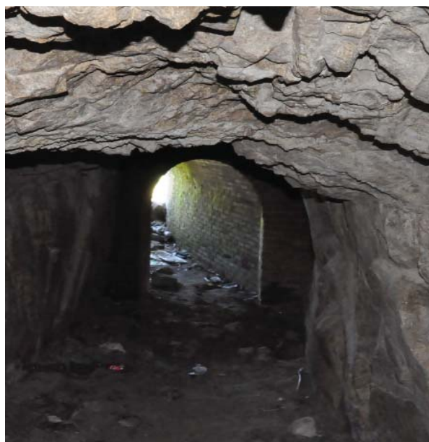
Túnel de salida del polvorín
