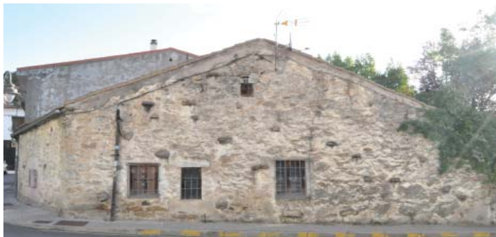
Vivienda rural en la calle Barrio de Arriba
