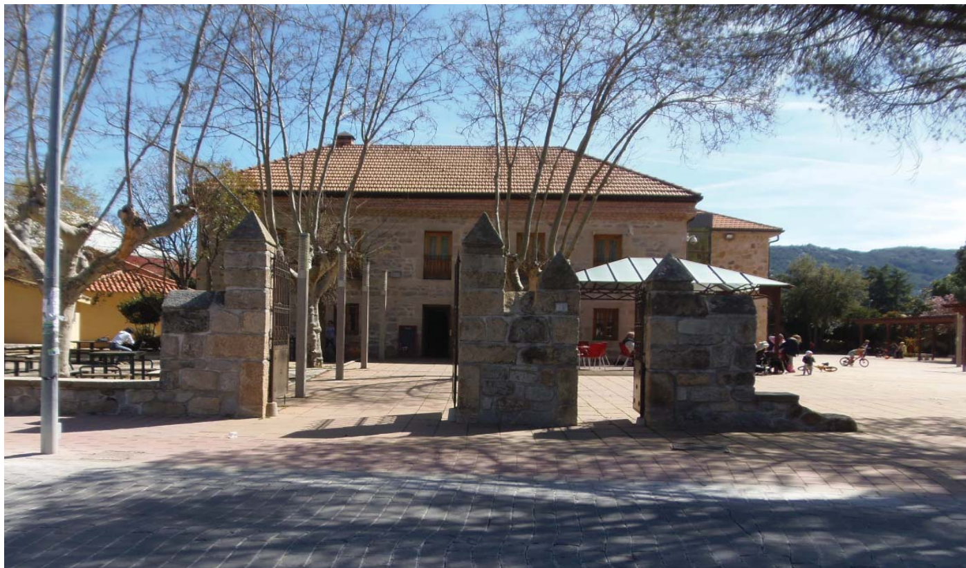
Vista frontal con restos del muro de piedra que rodeaba el edificio
