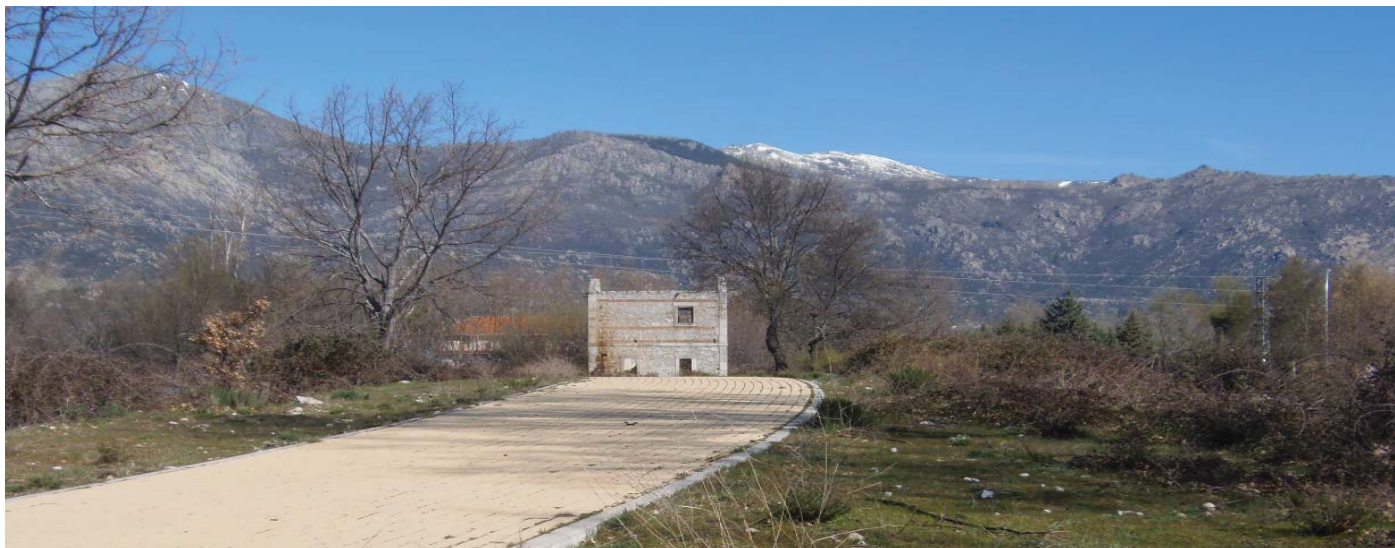
Panorámica del antiguo trazado de la línea férrea con la estación al fondo
