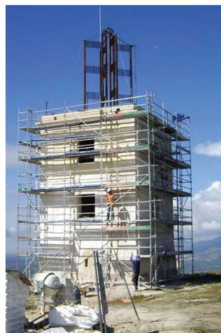
Obras de restauración de la Torre del Telégrafo
