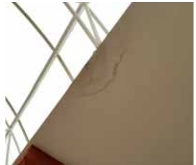
Efecto de goteras en el Centro Cultural: suelo y cúpula
