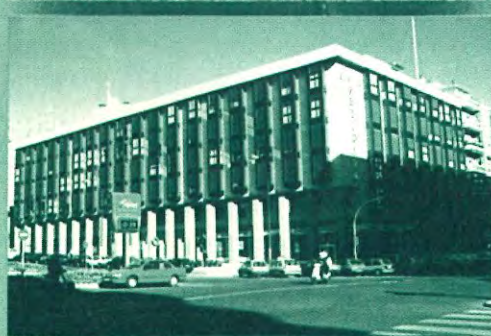
EDIFICIO PRYCONSA (MADRID)
