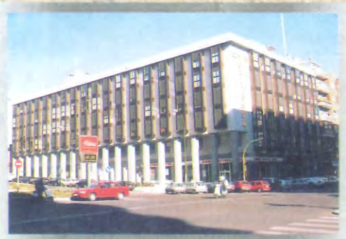
EDIFICIO PRYCONSA (MADRID)
