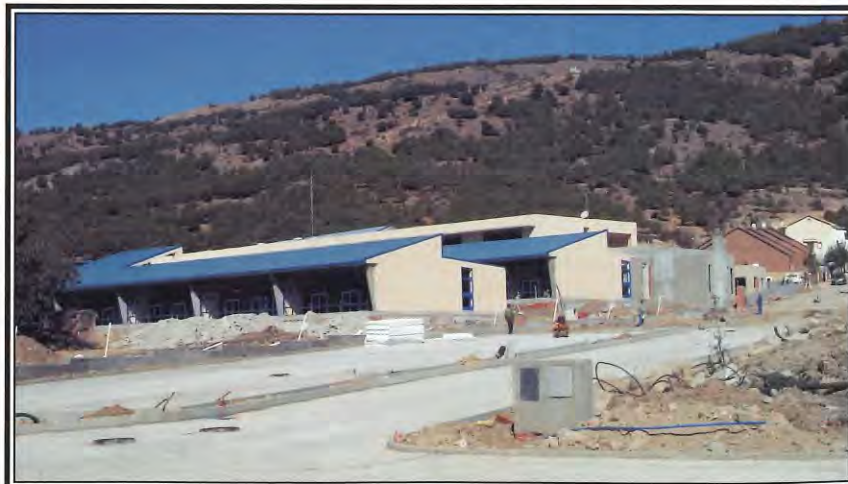
En la foto, Colegio de Educación infantil y primaria en ejecución.
