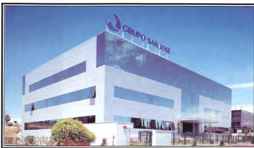
Sede Central del Grupo San José en Tres Cantos (Madrid).
