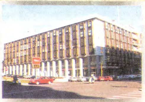
EDIFICIO PRYCONSA (MADRID)
