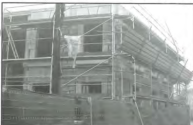
Obra de ampliación del Ayuntamiento
