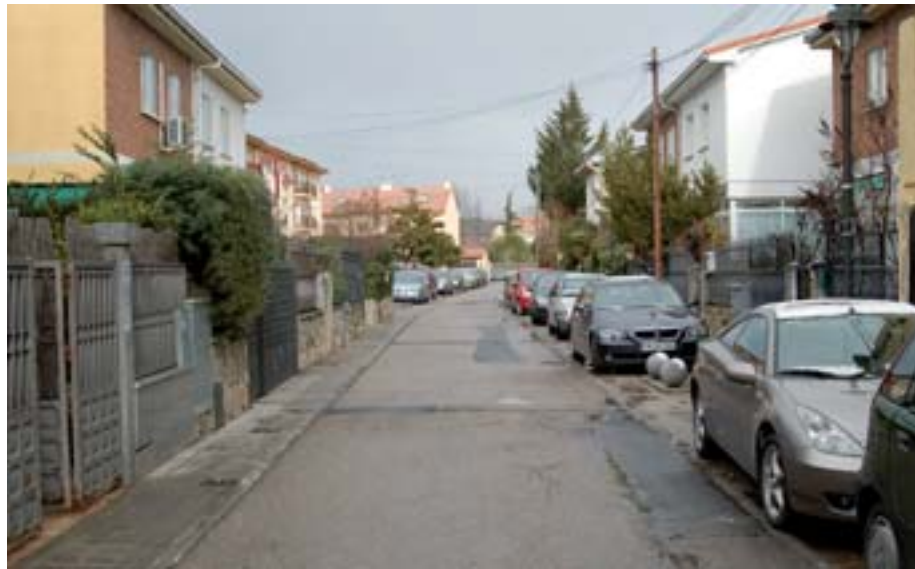
Las obras comienzan en las calles Cruz y Mesón y se irán ampliando a lo largo del año
